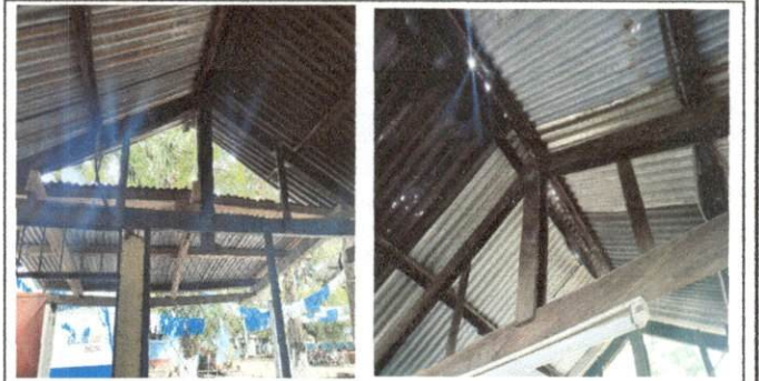
Foto 12: MODULO C Vista de Cubierta de lamina de zinc con staneras de madera.
