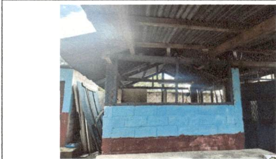
Foto 11: MODULO C COCINA Suttitucion de estructura de madera y lamina de zinc por estructura portante de metal con lamina troquelada cal 26
