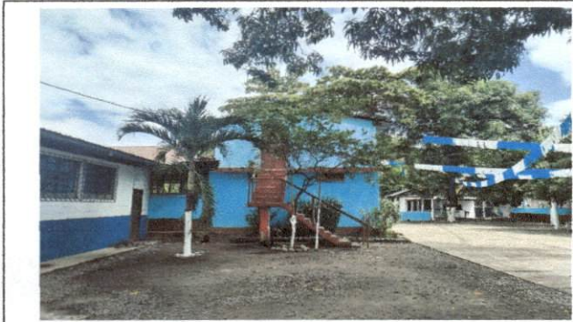
Foto 7: MODULO B Cambio de lamina y estructura de madera por estructura de metal y lamina troquelada cal 26.
